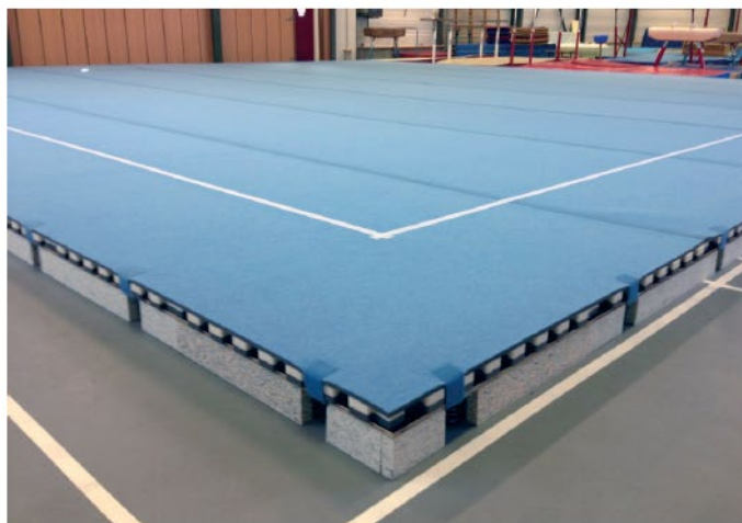
Blocage en rotation de la mousse et de la moquette par verrouillage velcro
