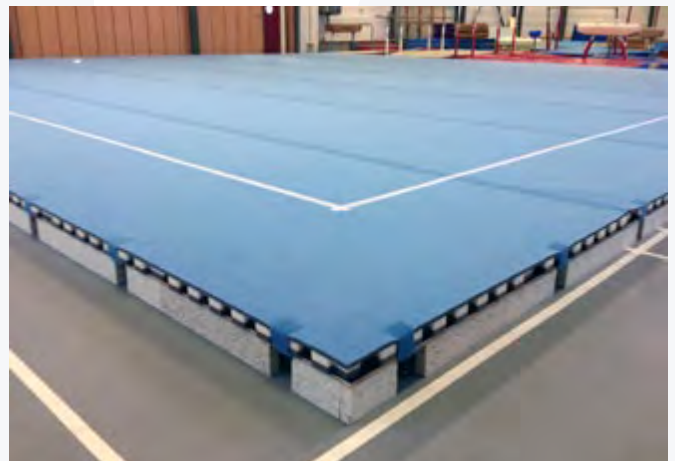
Blocage en rotation de la mousse et de la moquette par verrouillage velcro.
